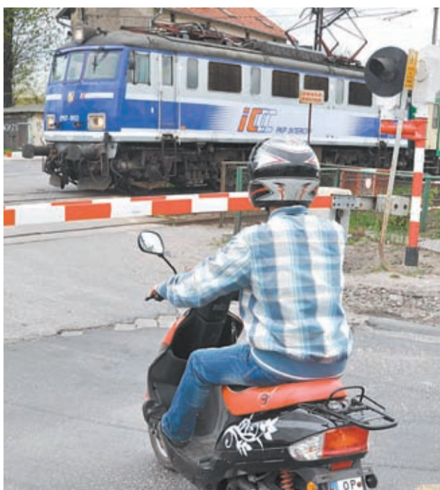
Przejazd kolejowy w Opolu (obok Nutricii) zostanie wyremontowany jeszcze w maju.
